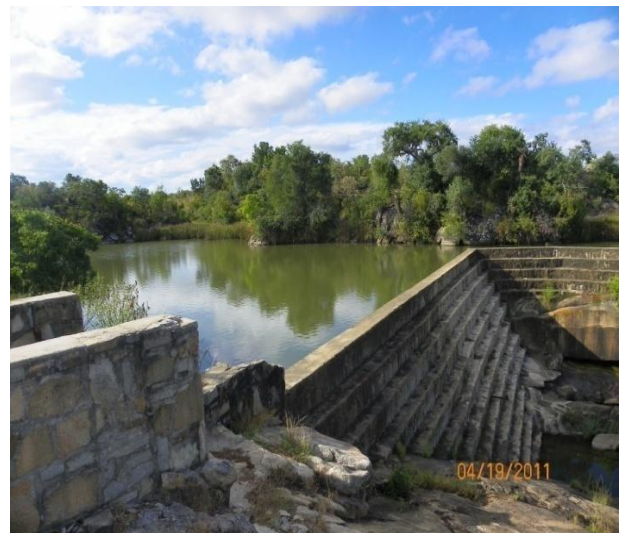
(d) Village 4 Dam in Ward 19
